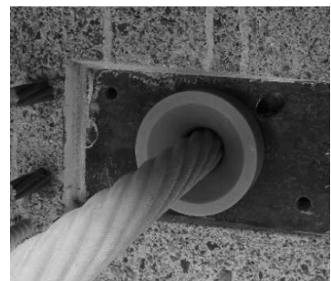
写真 4-6-2 (2) 傷防護治具の使用状況
